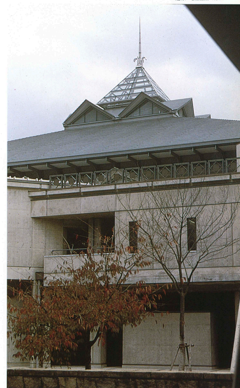
西側外観部分 Partial view of the west side.
