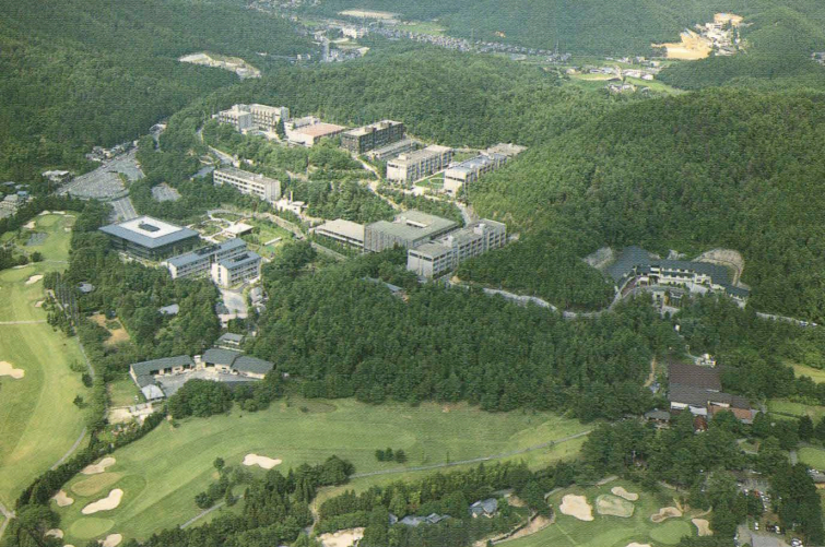
キャンパス全景 Aerial view of the campus.
