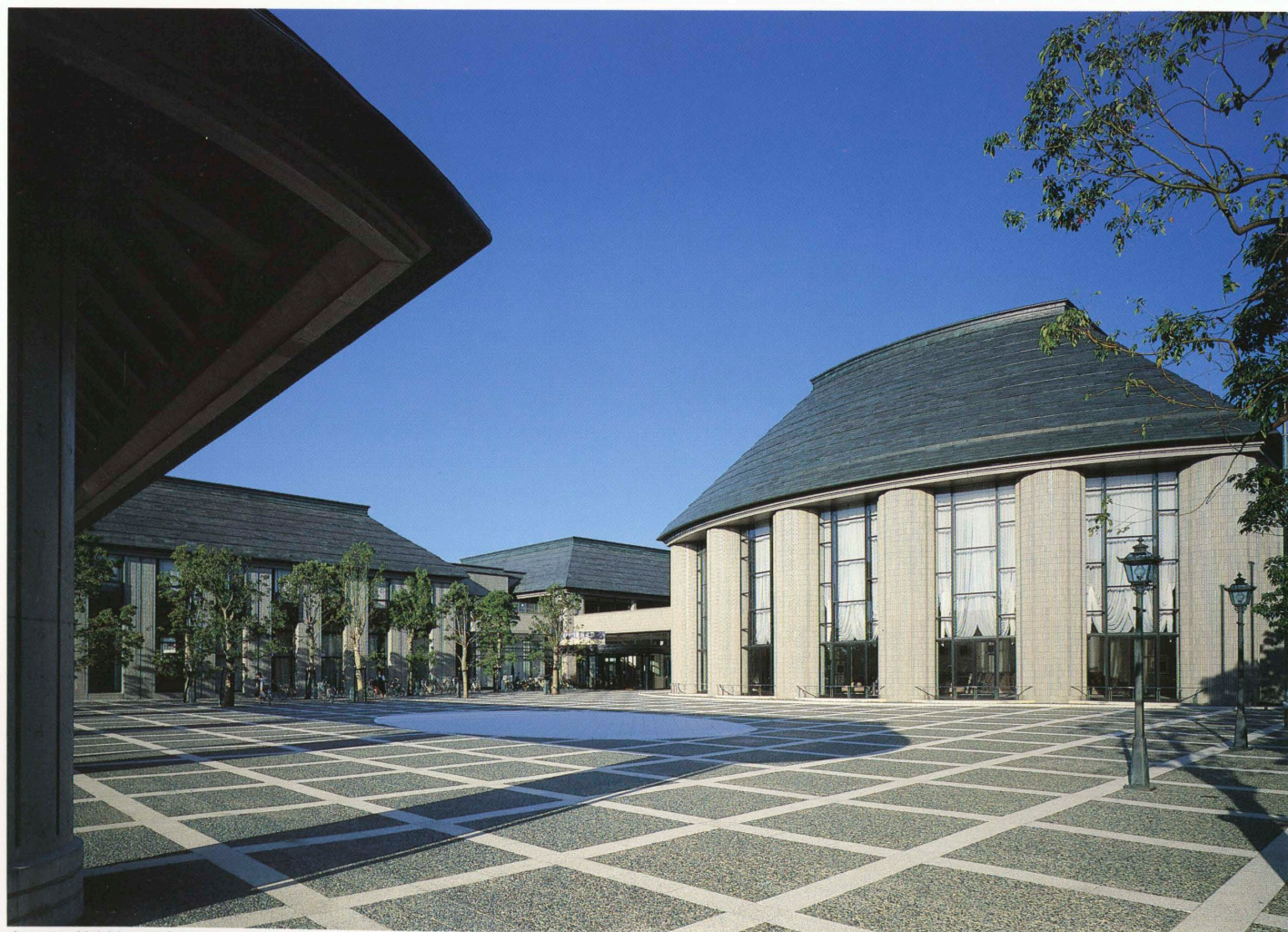
大ホール棟(右)と図書館棟(左)外観 General view.
