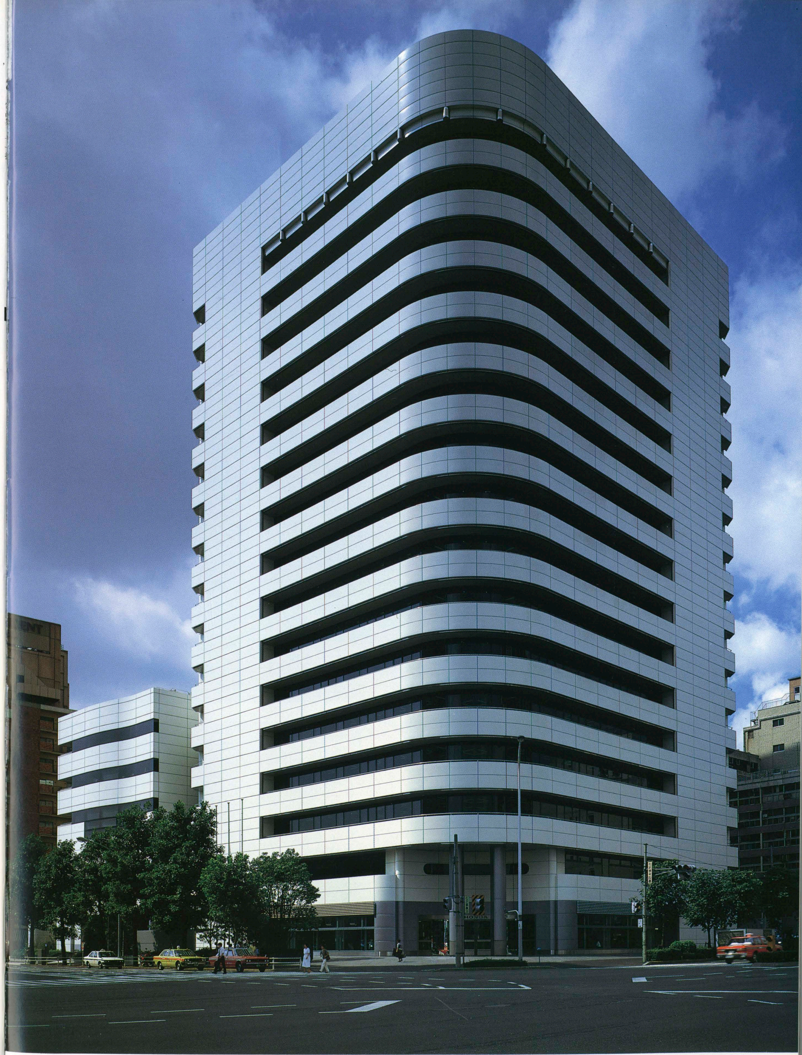
交差点より見た全景 General view.
