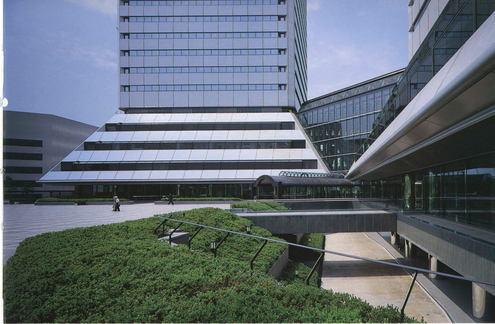
プラザからタワーへのブリッジとその下の車寄せ Bridge and porte cochere to the tower.
