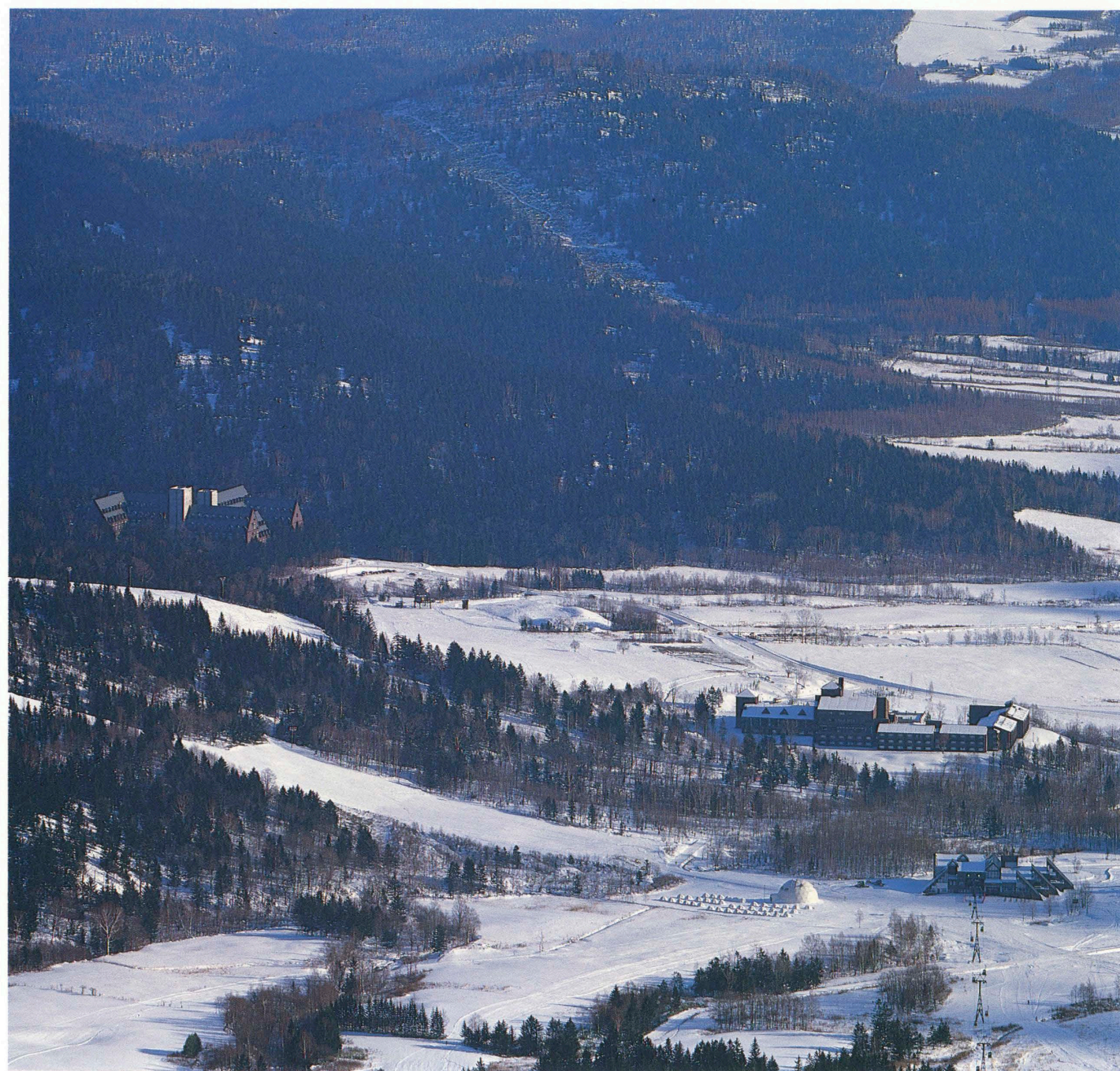
西側からの遠望(左中央、右下は 1 期工事で完成の施設) Distant view (middle on the left).
