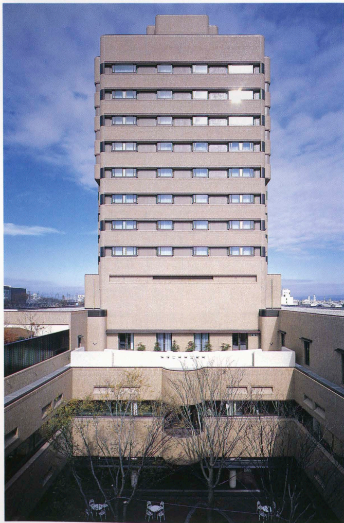
ホテル客室棟と広場 Guest room wing and plaza.
