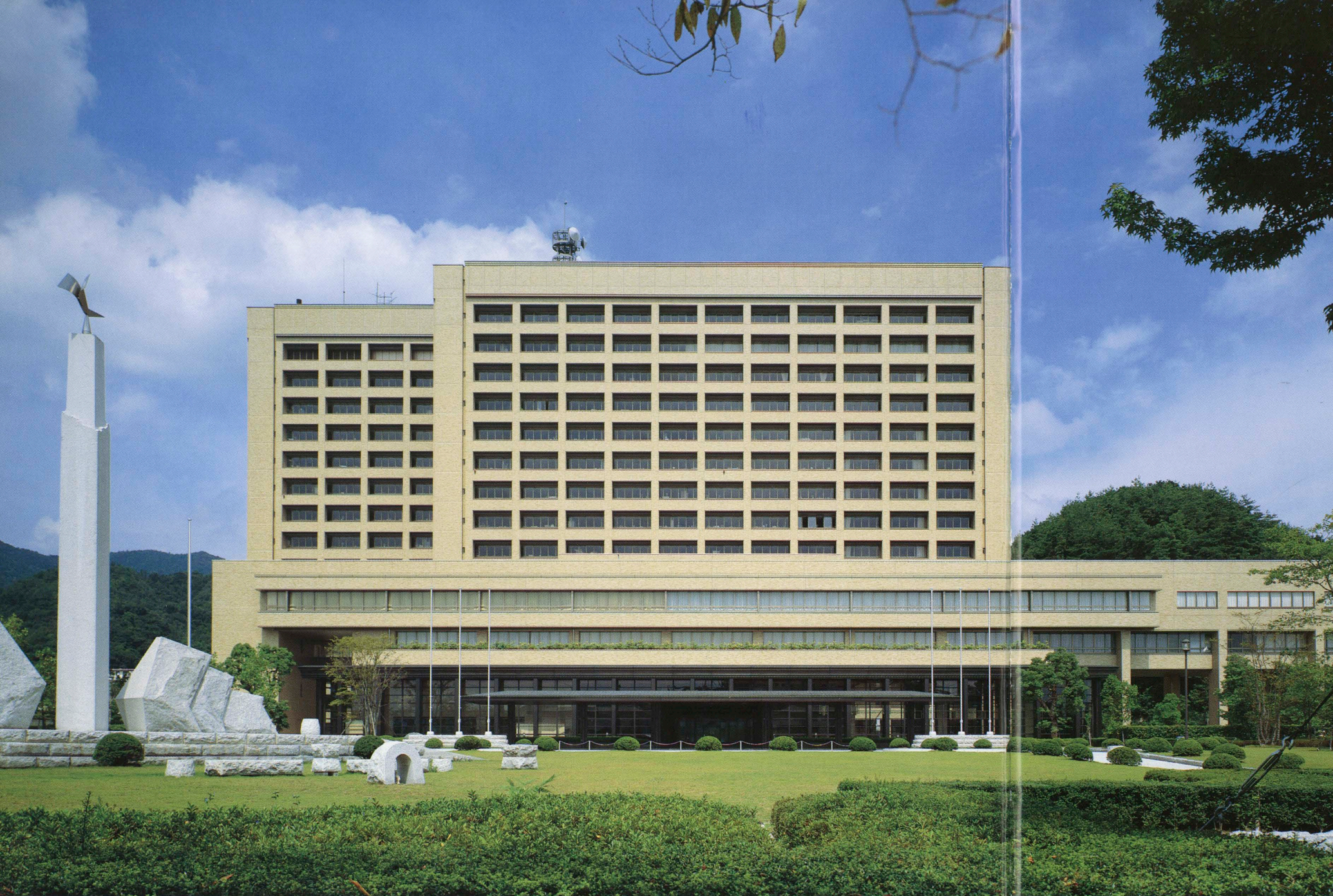
全景 General view.
