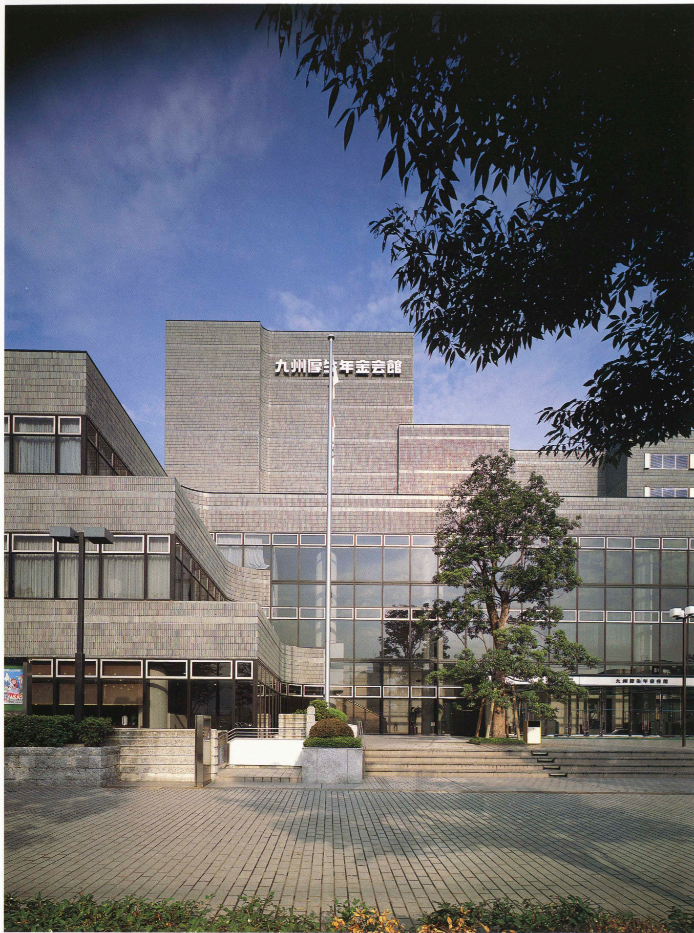
正面エントランス回り Around the main entrance.
