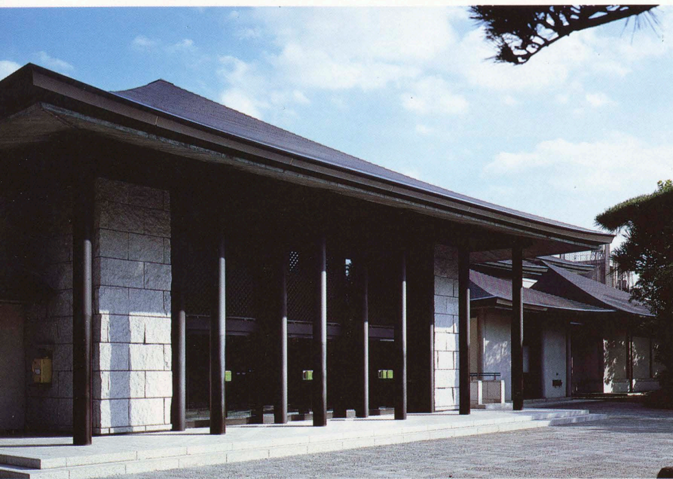
正面玄関廻り Entrance.
