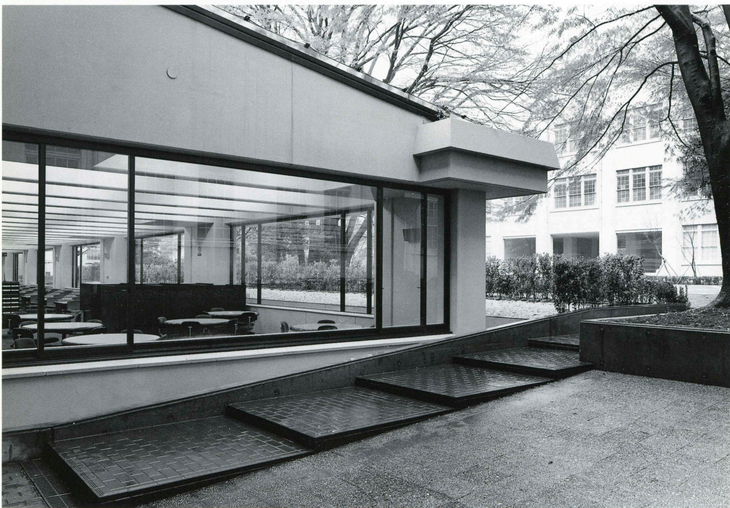
図書館アプローチ回り／Approach of the library
