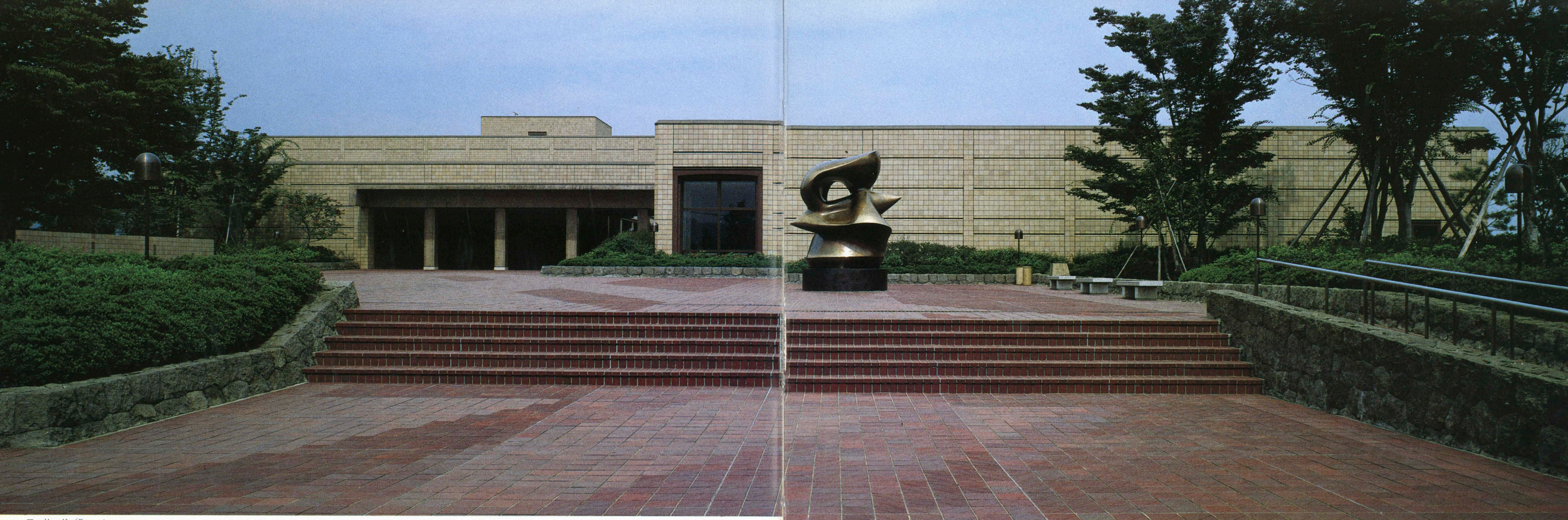
ファサード/Facade
