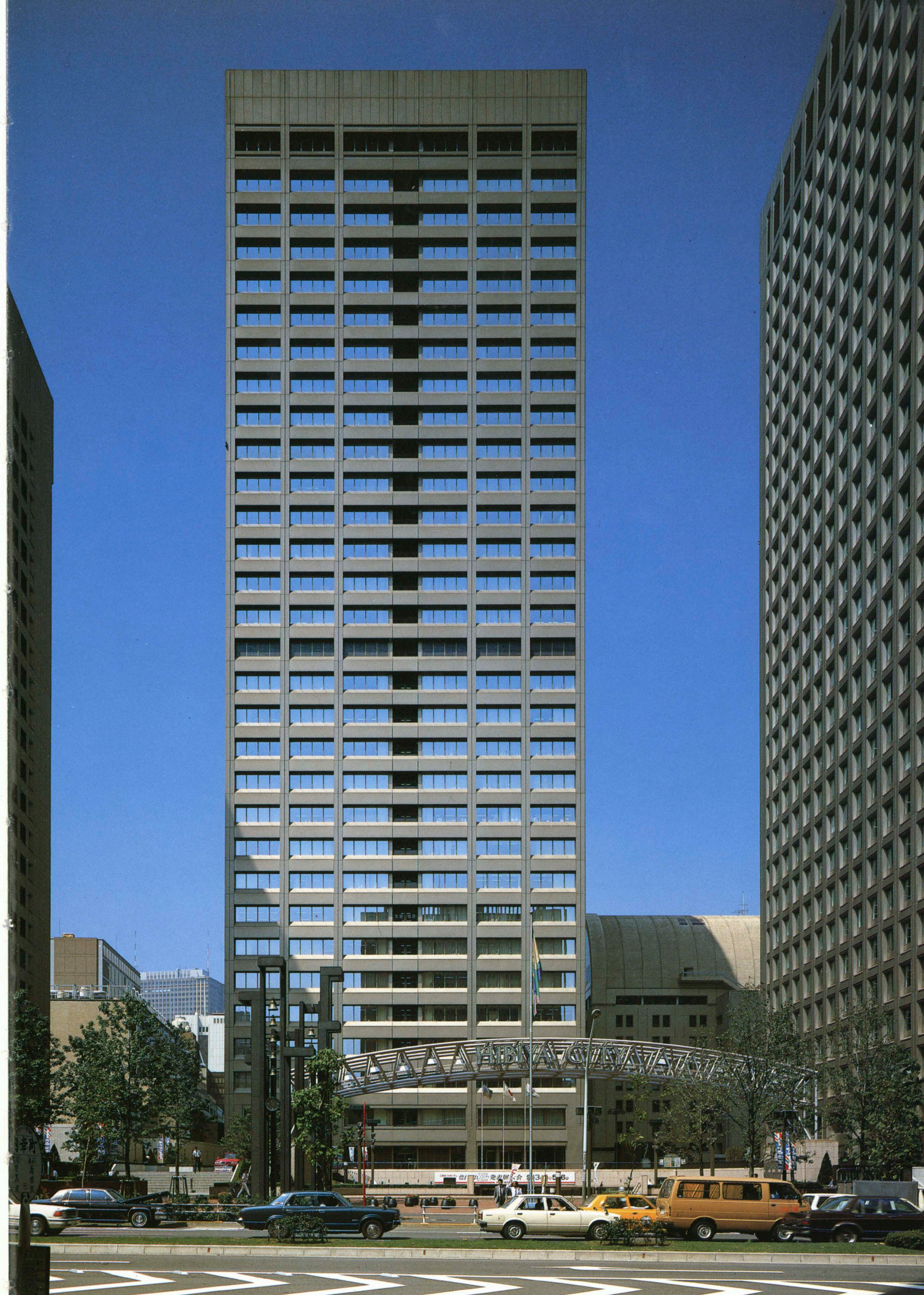
右：東側外観 / right: East elevation
