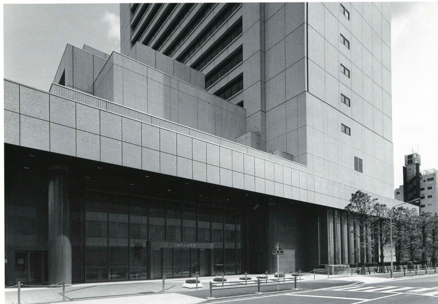
高層棟(日産自動車新館)エントランス / Entrance of the tower
