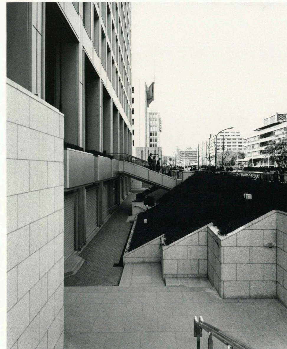
サンクンモール Sunken mall.
