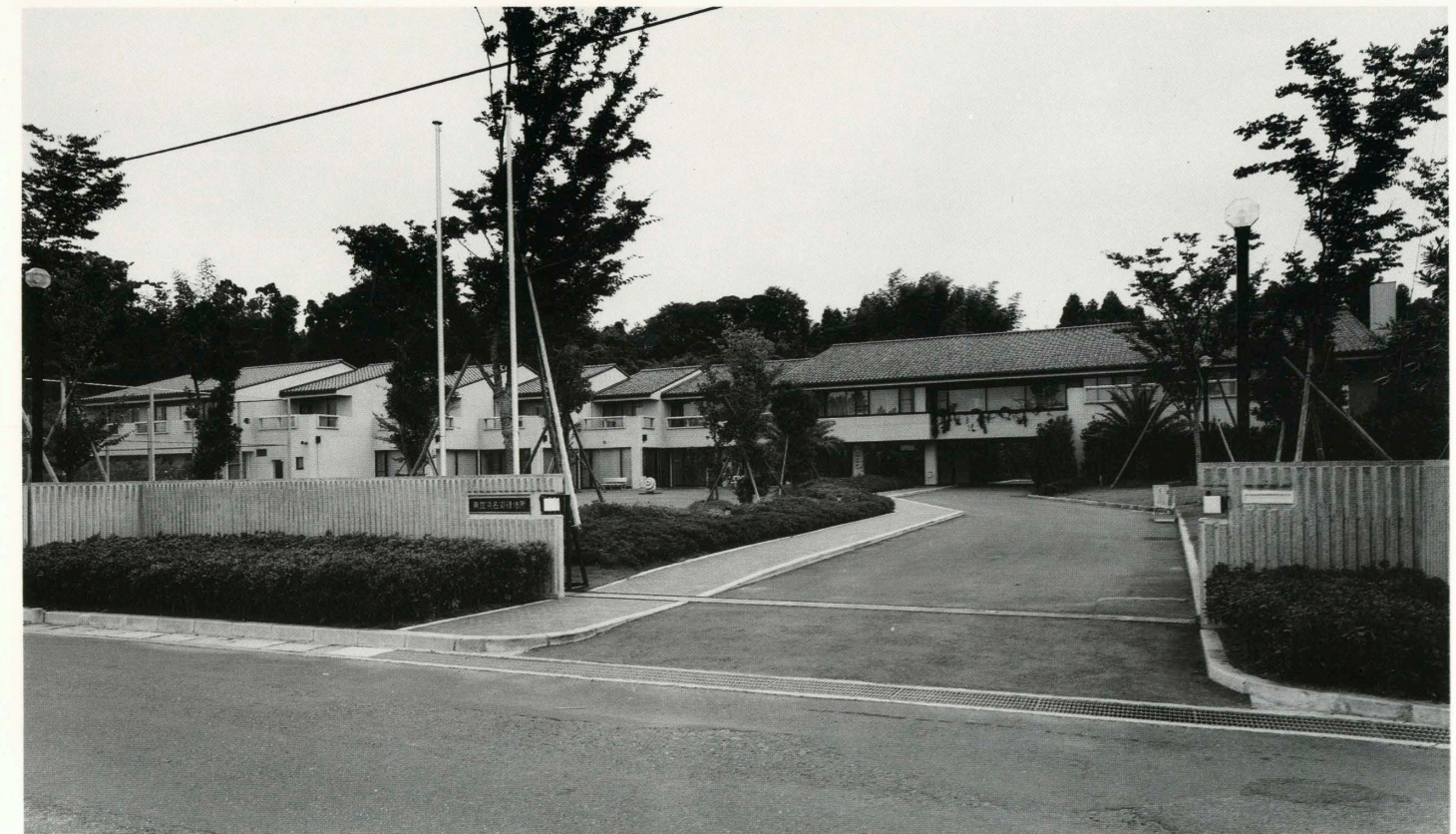
正面アプローチよりみる View from the approach.
