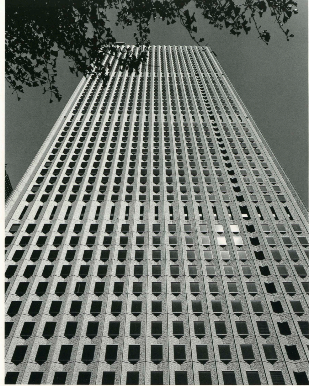
外壁見上げ Upward view.
