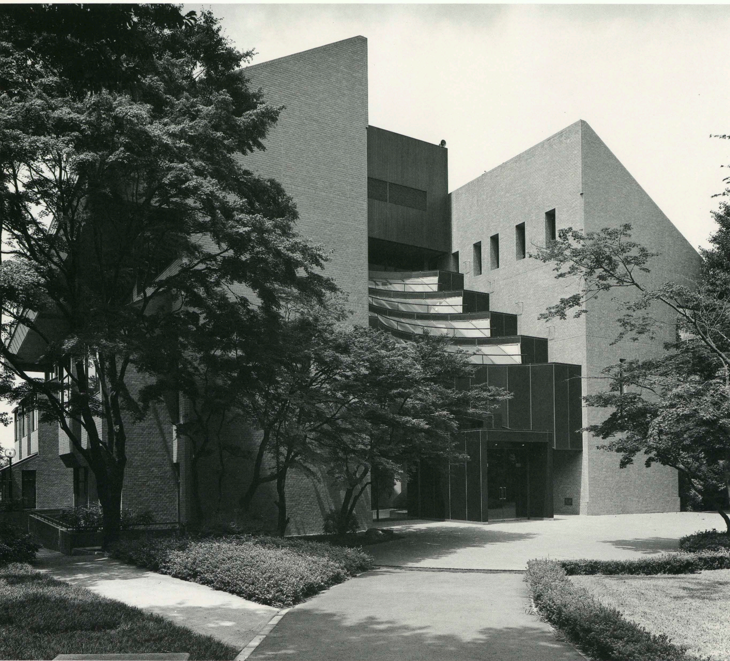
正面全景 Front view.
