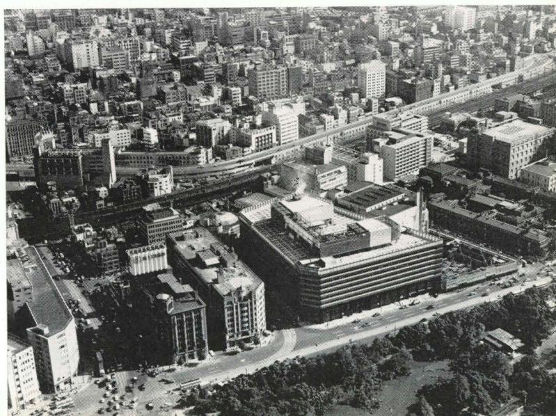
空から見たビルの全景 bird-eye view
