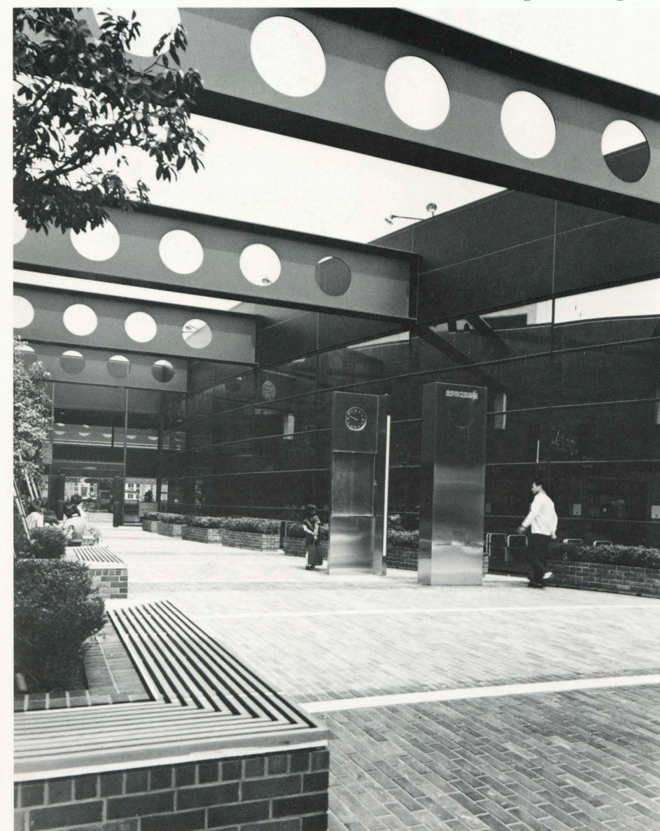
南側中庭。 Courtyard.
