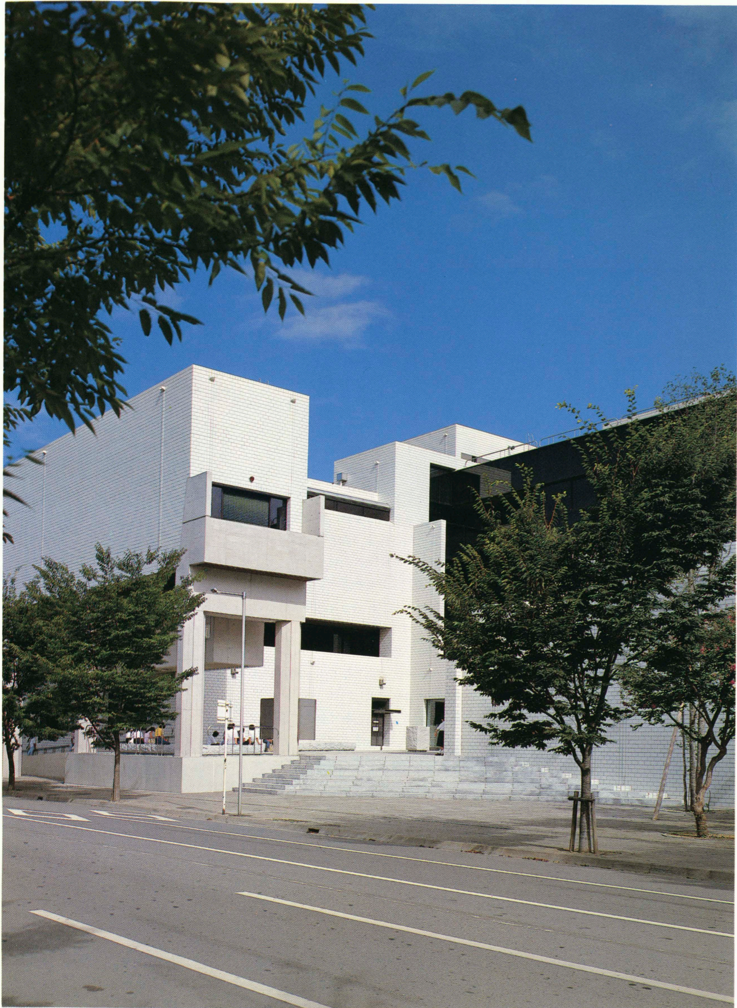
正面アプローチ Main approach.
