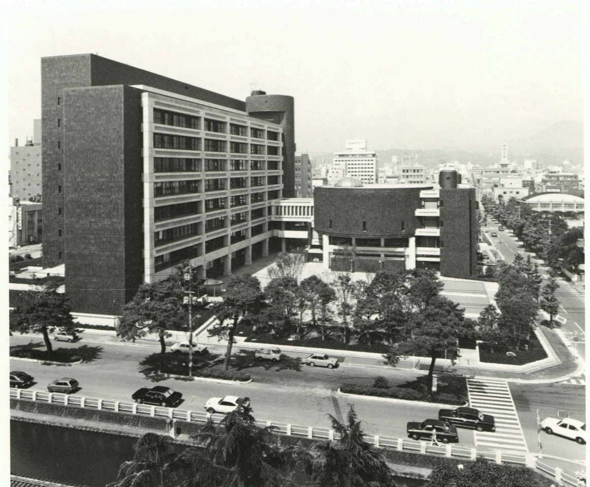
東側からみた全景 General view from the east.
