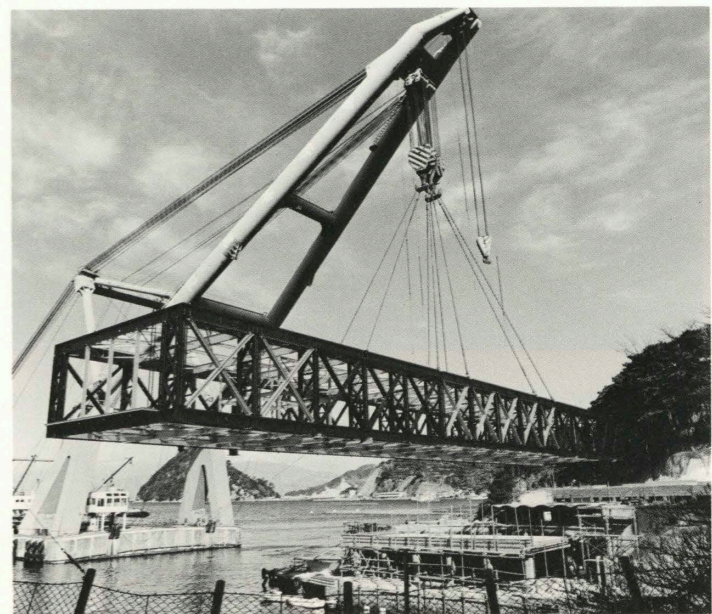
鉄骨フレームを吊り上げセットする Main steel frame.
