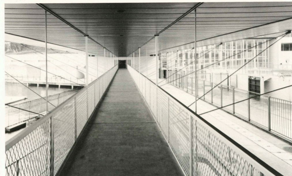
主棟下部のブリッジ Bridge below the main building.
