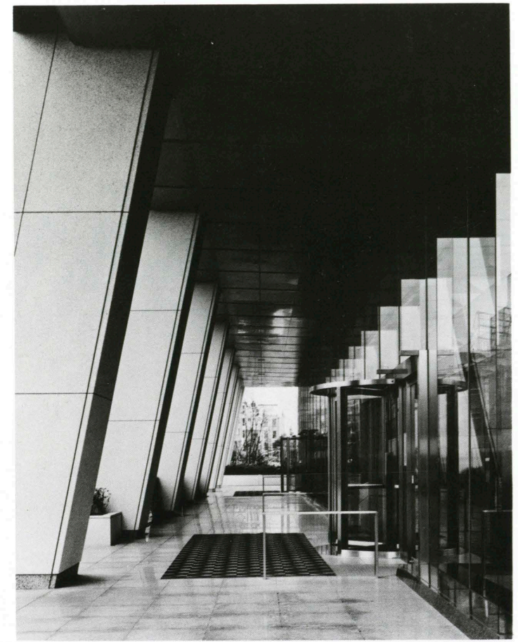
正面入口 Entrance area.
