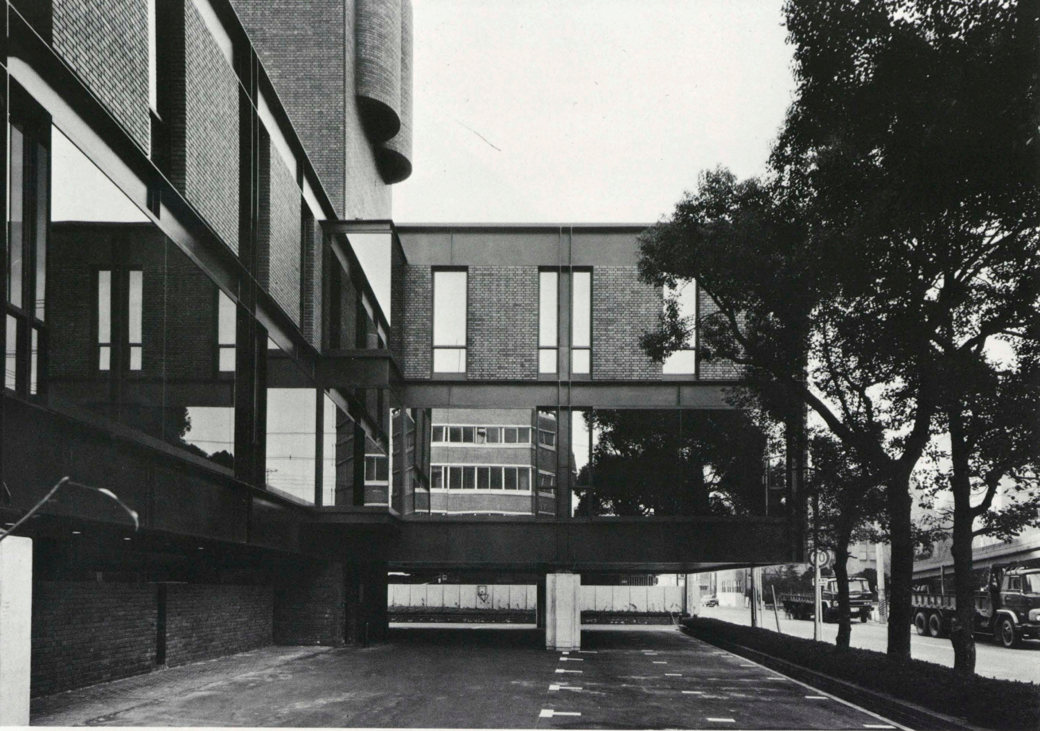
西側ピロティー Pilotis seen from the west
