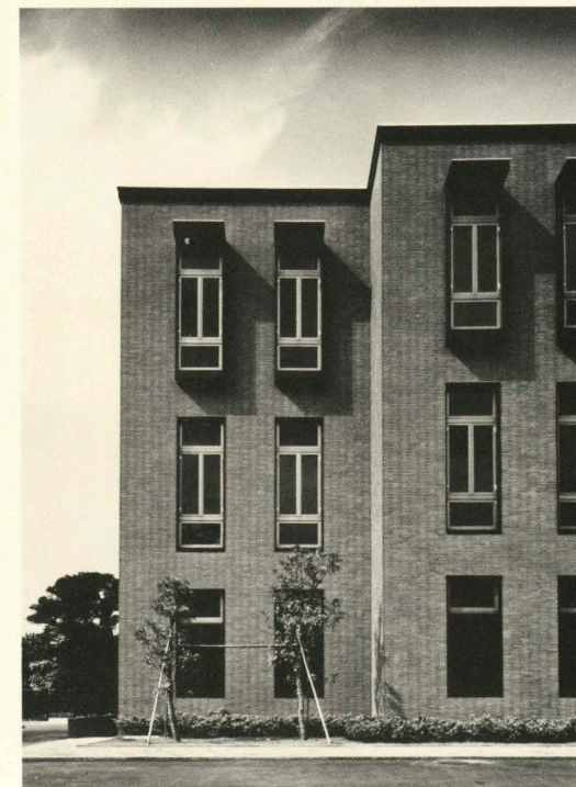
北側隅部 North side corner.
