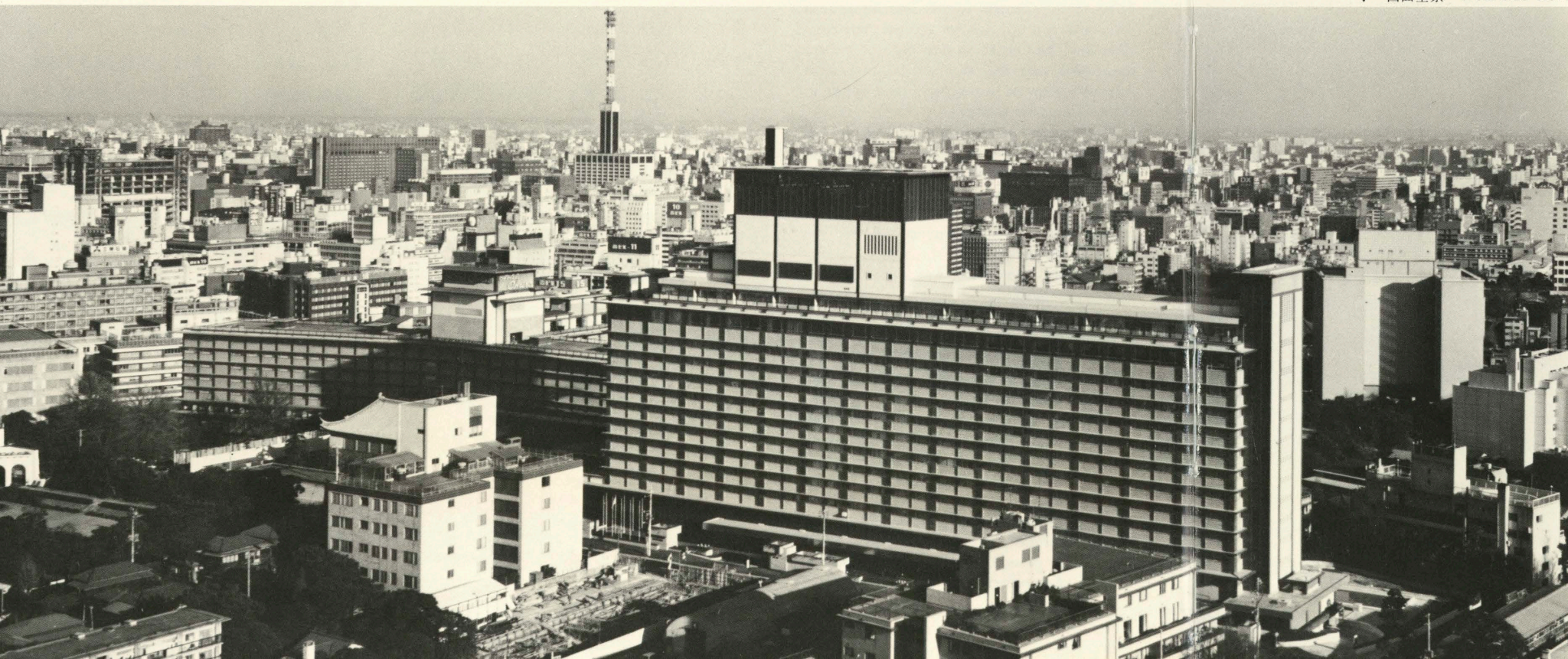
↓ 西面全景 West side view.
