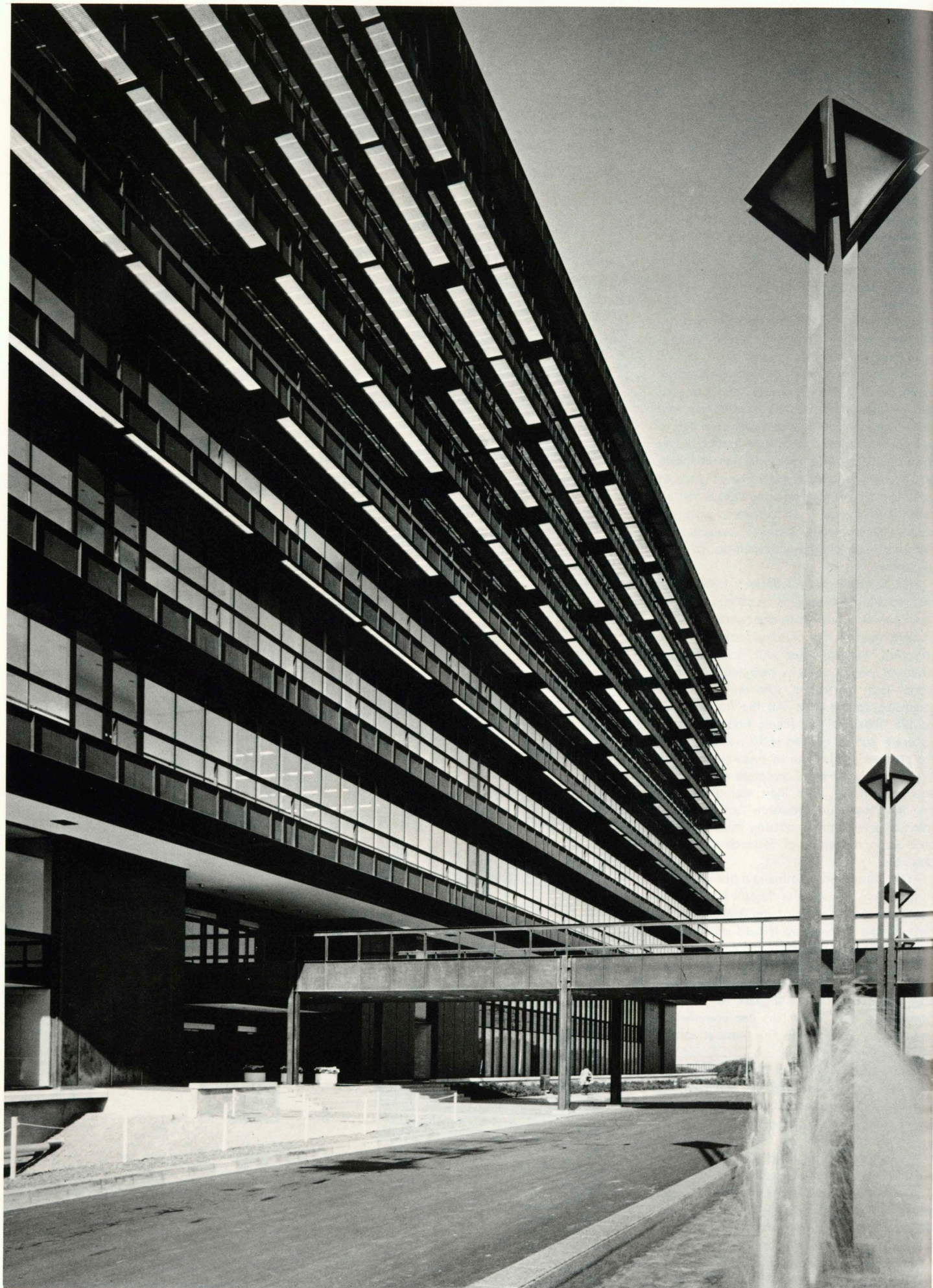
正面外観 General view
