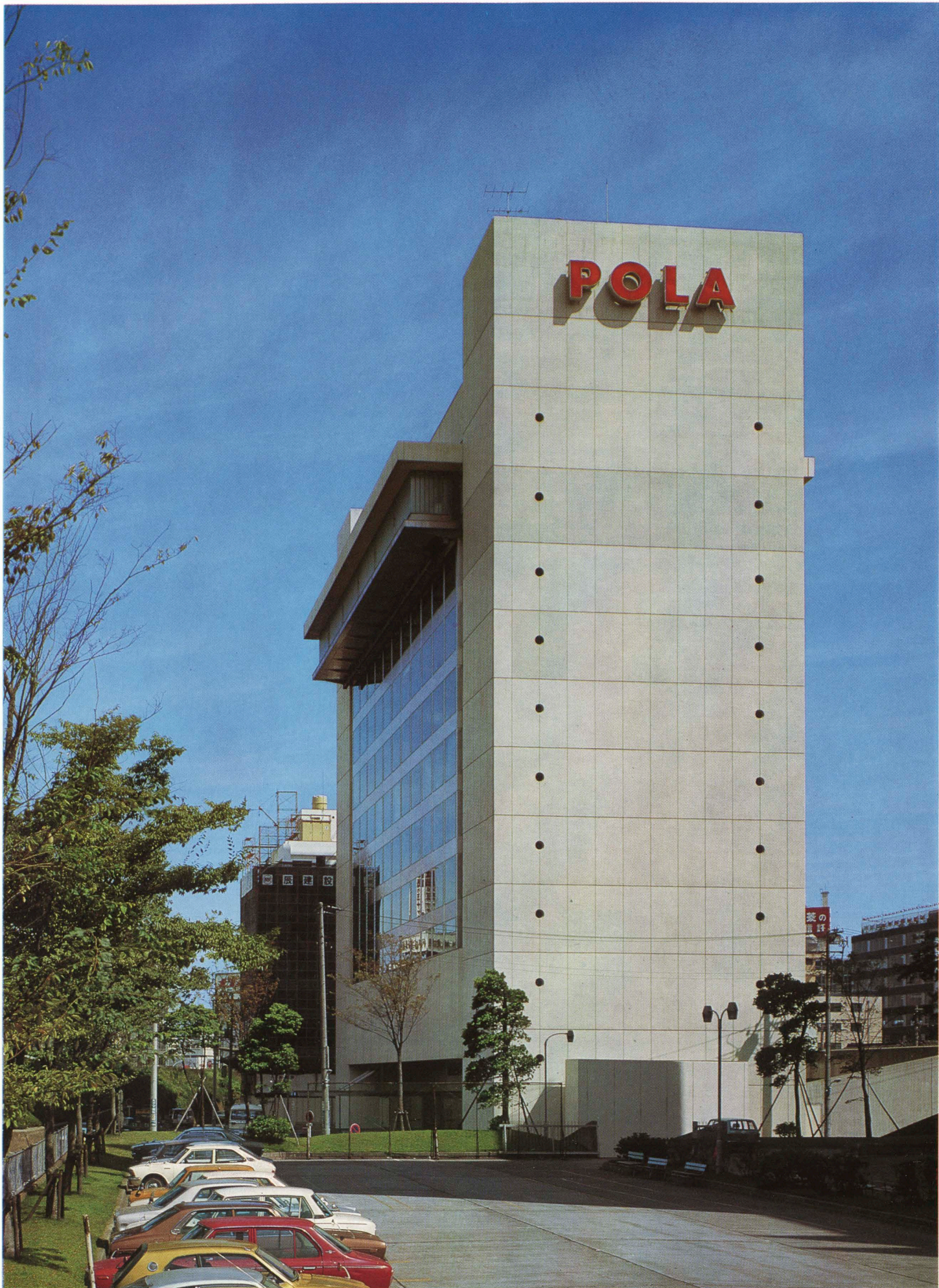
西面全景 West side view
