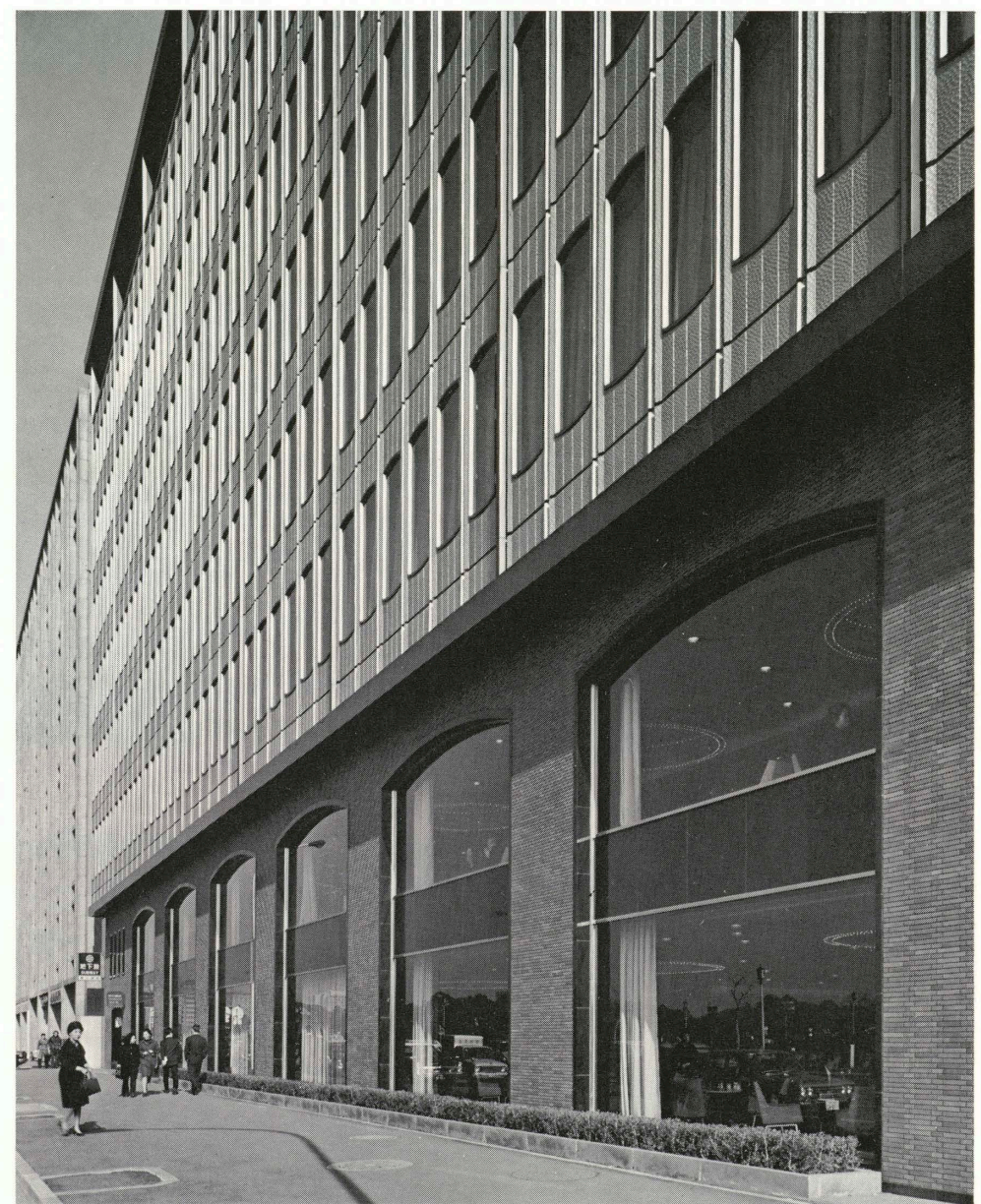
全景 General view
