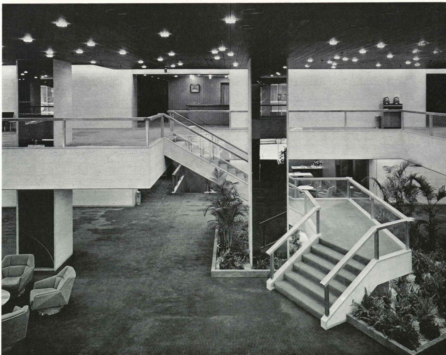
ホール階段 Stair way
