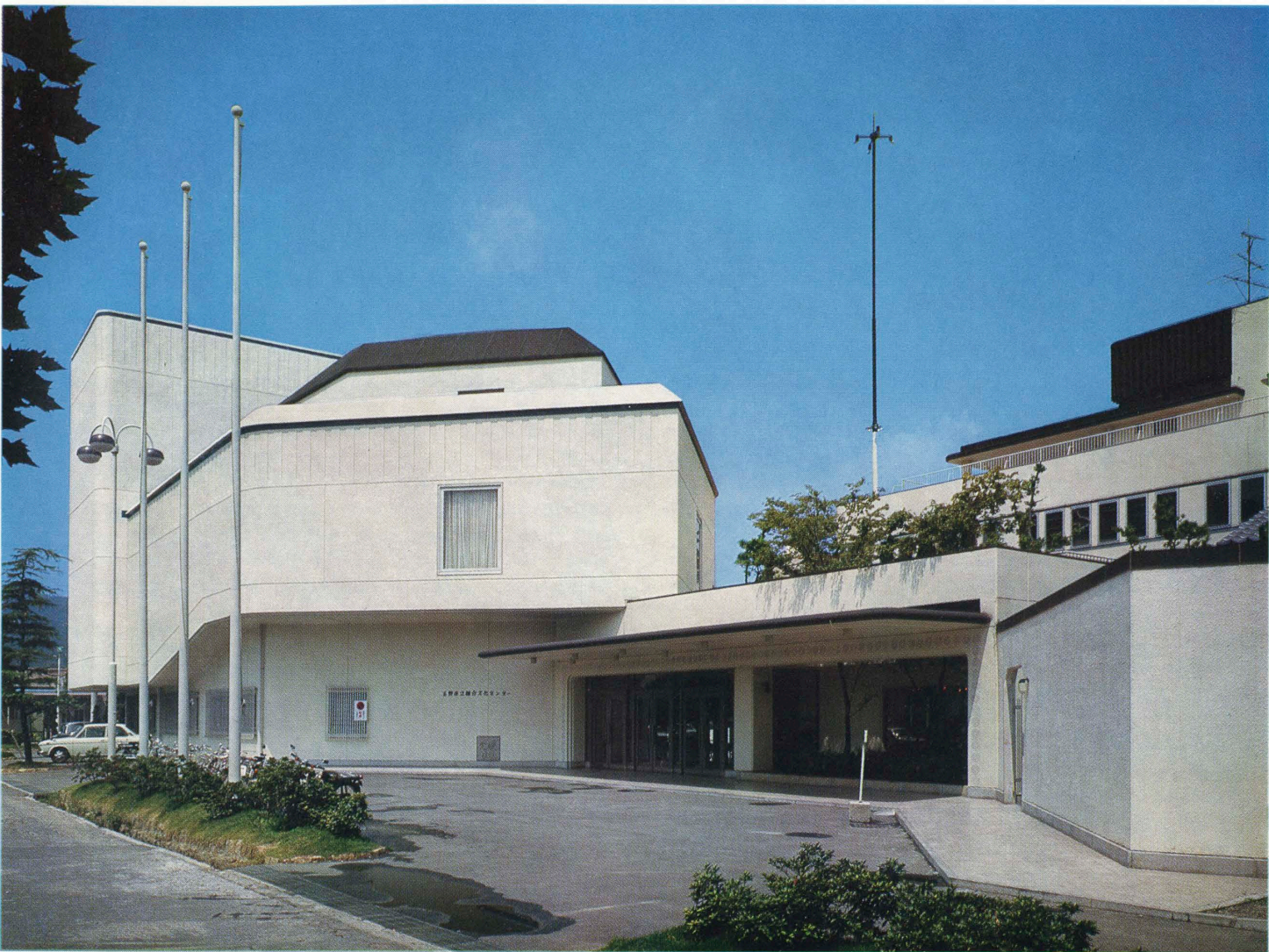
正面全景 General view
