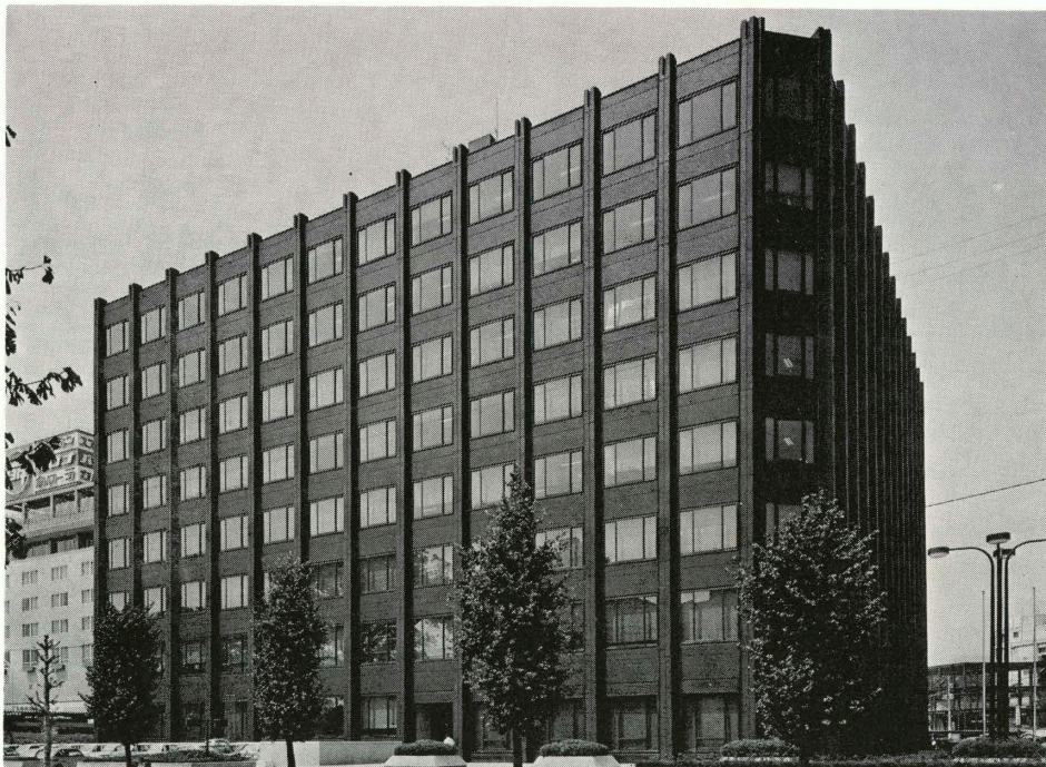
東面全景 East side view
