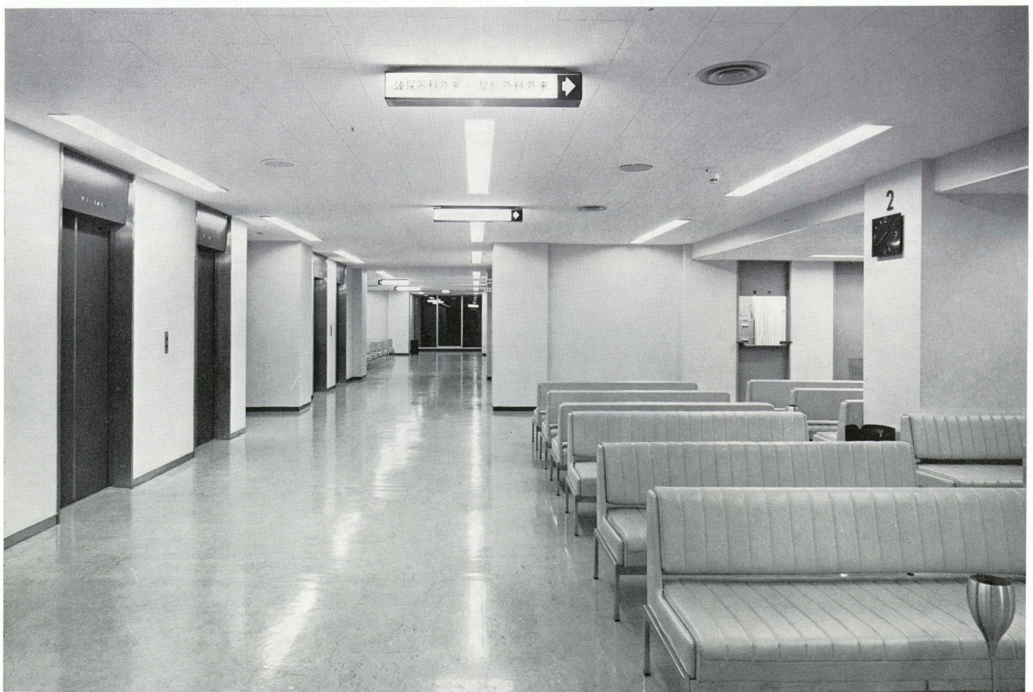
エレベーターホールと外来待合室 Elevator hall and open space
