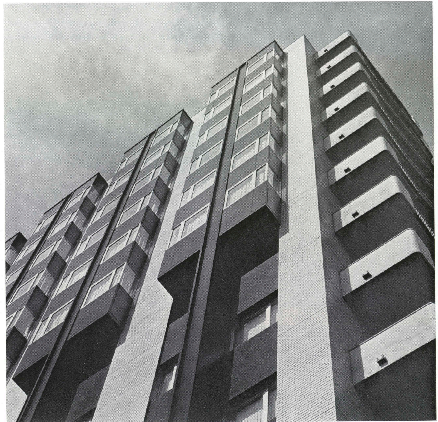
外観部分 Part of the exterior
