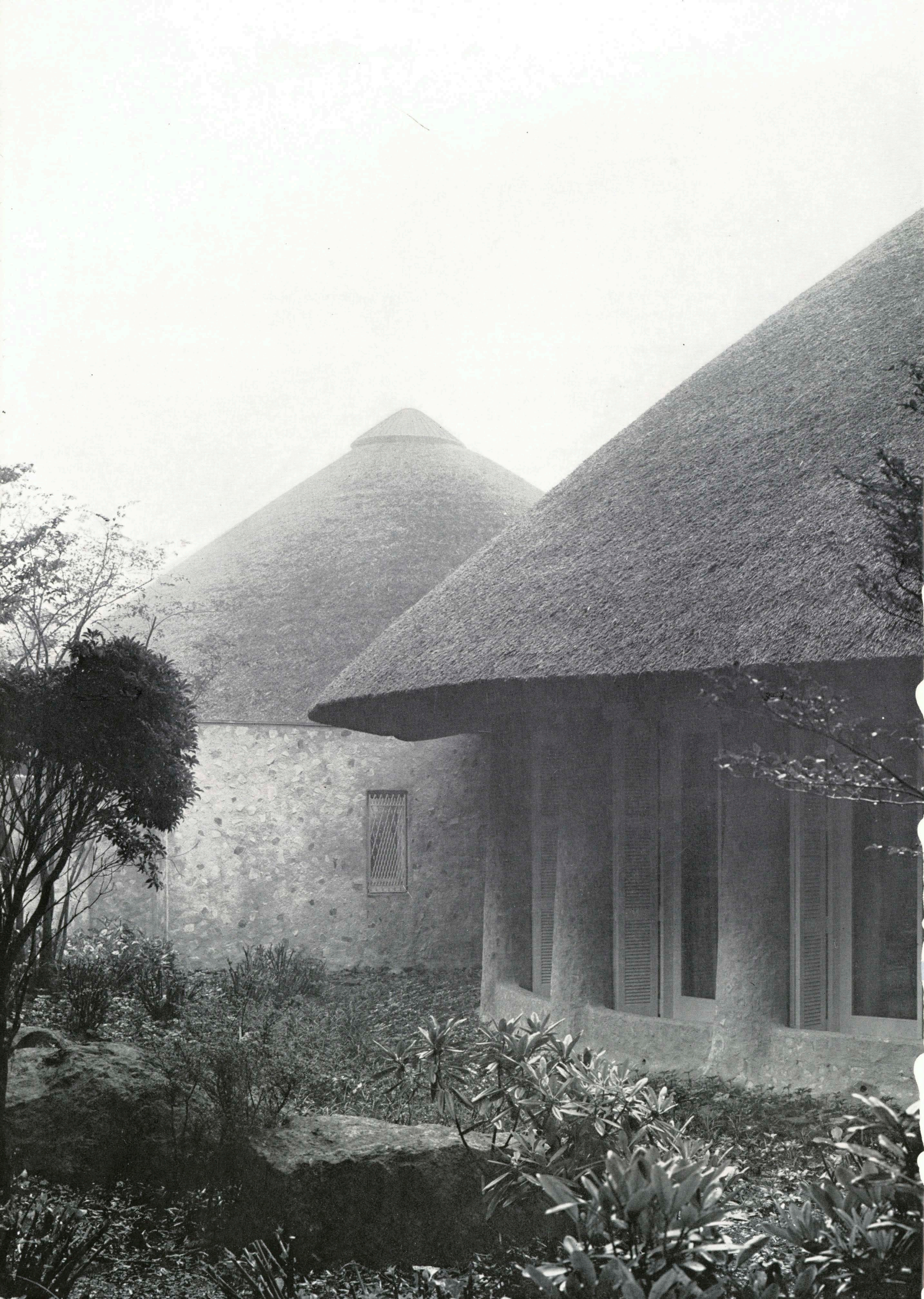
外観部分 Part of the exterior
