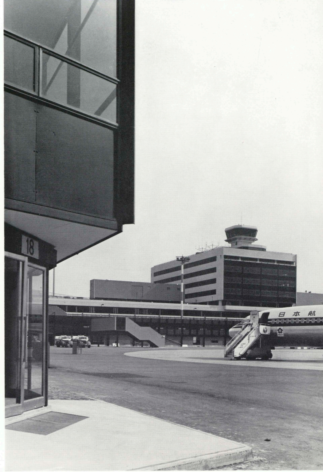
フィンガー先端部と管制塔 Finger end and control tower
