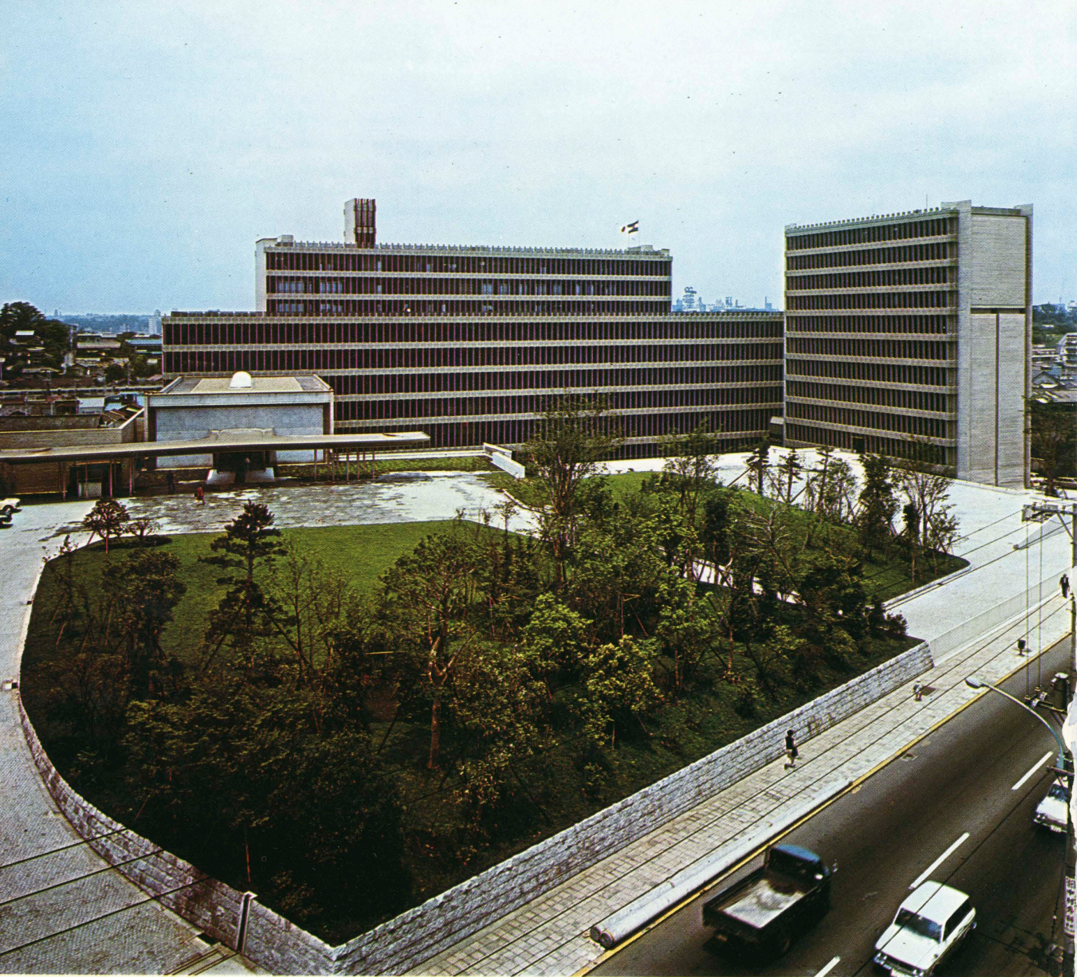
正面全景 General View
