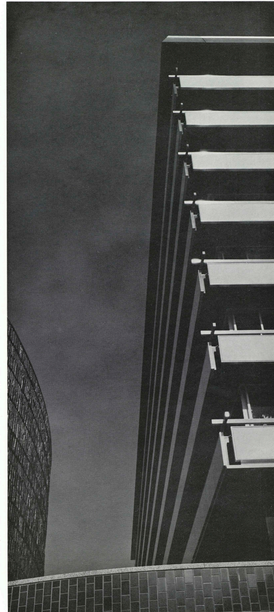
南西コーナーをみあげる Southwest Corner
