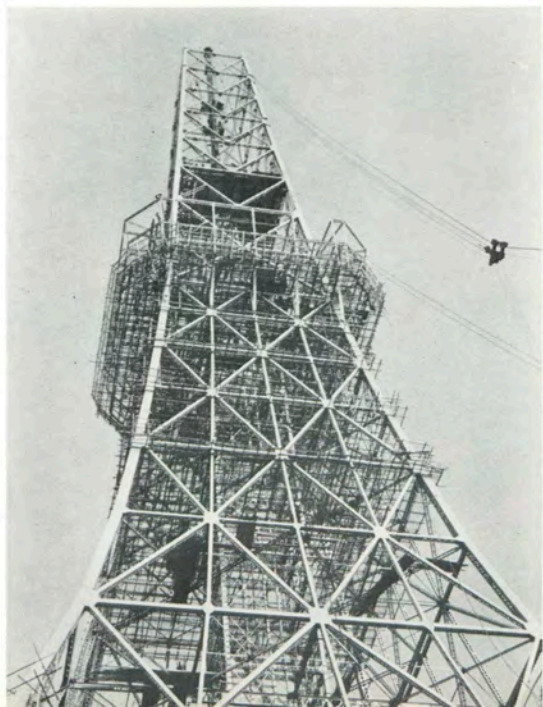
7.15 地上 200 m 附近 鉄塔建方中
