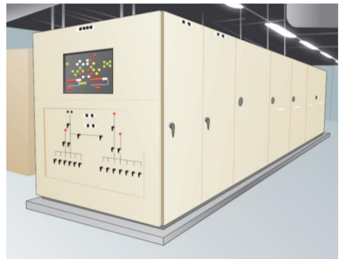
受変電設備の例
