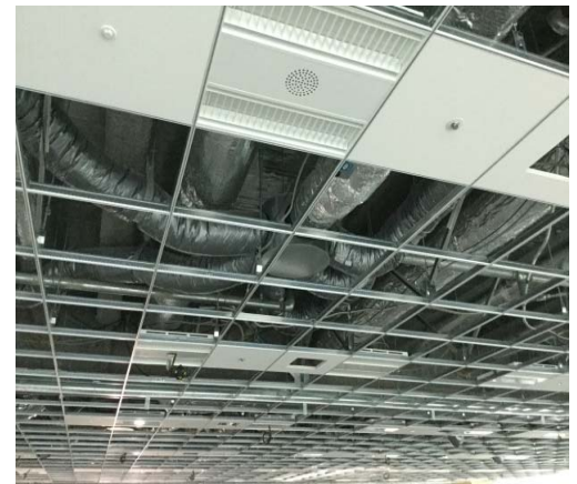
天井内施工状況
