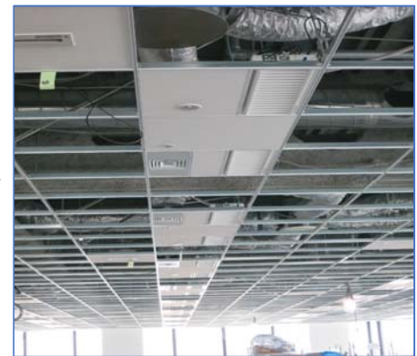
天井器具 設置工事
