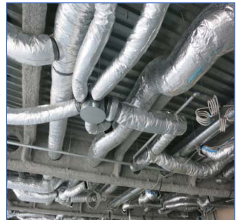
天井内設備 先行工事
