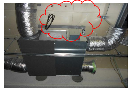
引き抜きスペース
