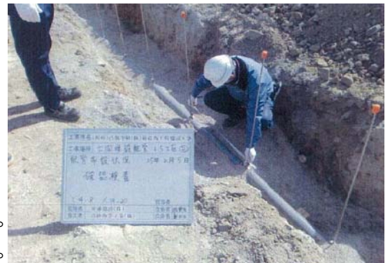
土間配管検査の例
