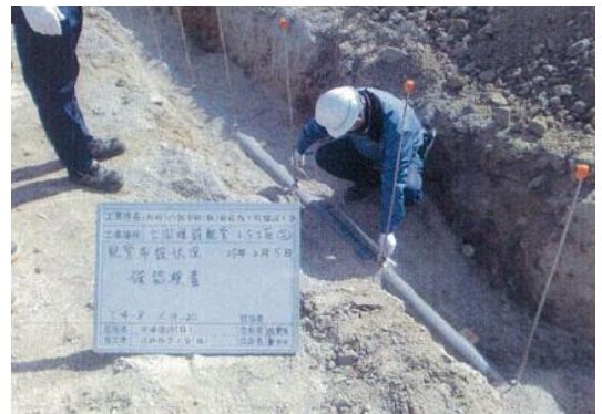
土間配管検査の例
