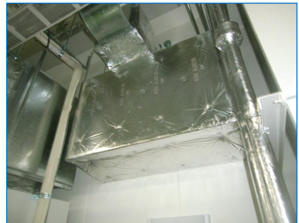
施工状況写真
