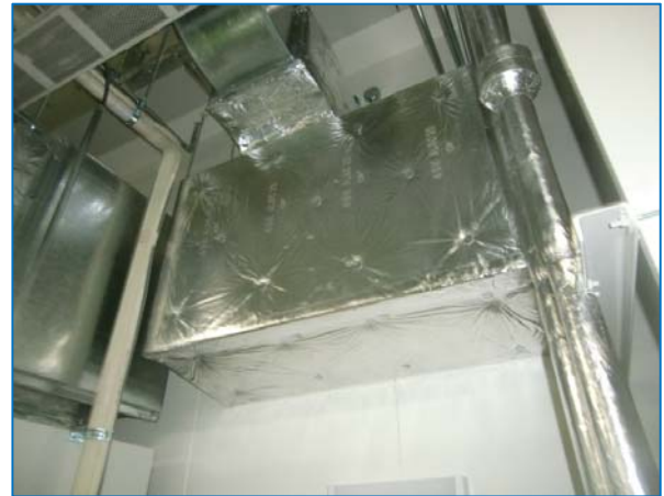
施工状況写真
