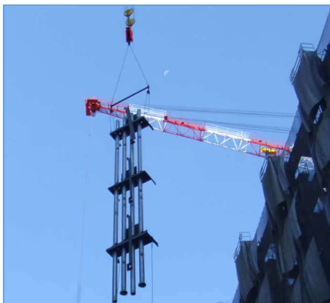
ライザー配管工法
