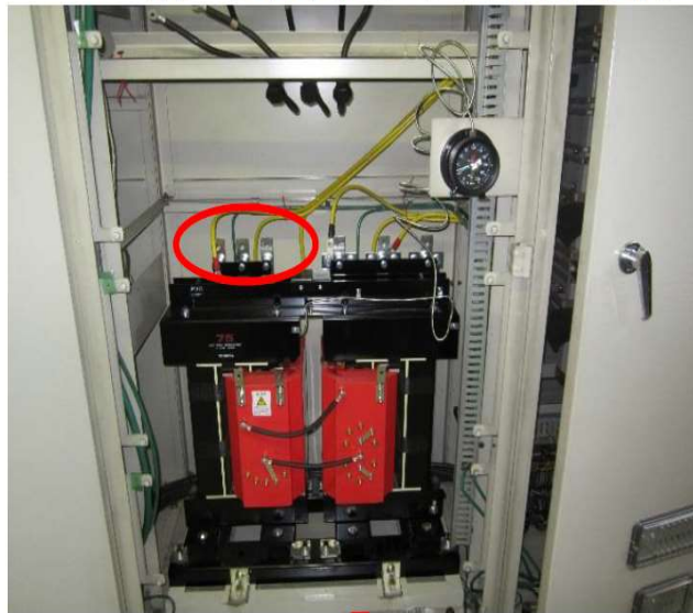
新設 設置状況(一次側端子接続前)
