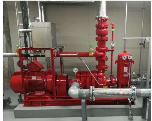
[消火ポンプユニット]
