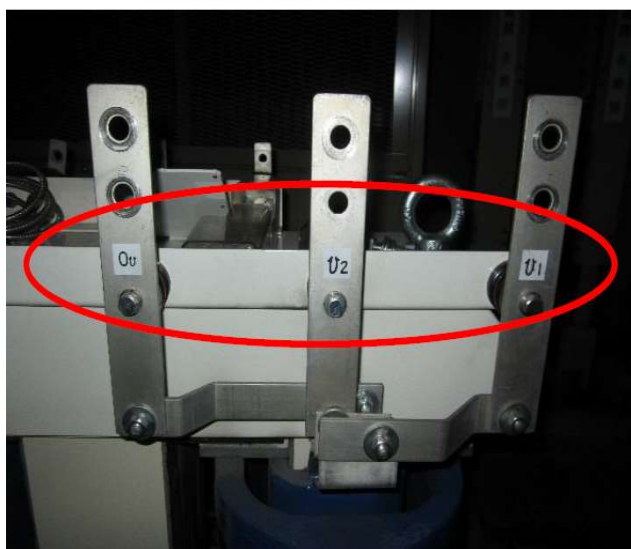
既設 二次側端子状況 (裏側から拡大撮影)
