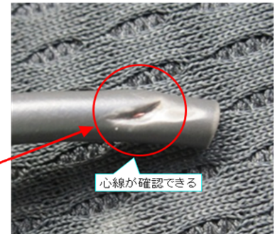
<ケーブル絶縁被覆の傷状況>
