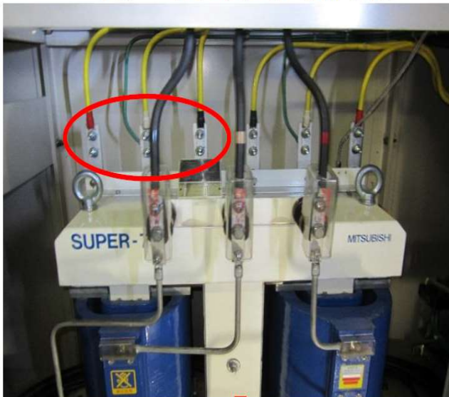
既設 設置状況(工事着手前)
