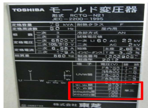
【新設トランス】
