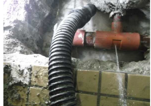
継ぎ手からの漏水状況
