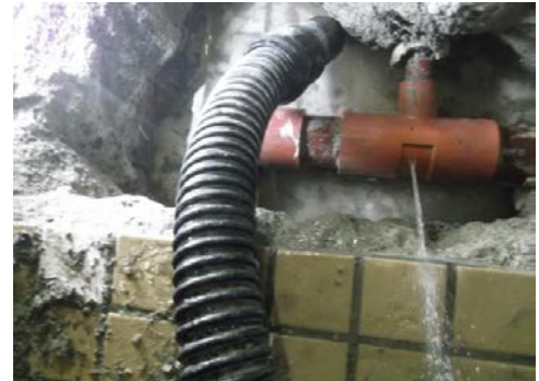
継ぎ手からの漏水状況
