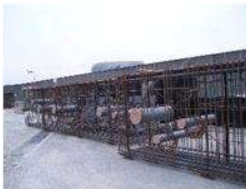
【梁鉄筋地組時にスリーブをセット】
