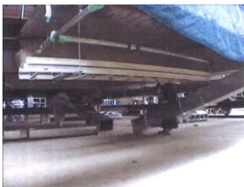
【地組みヤード】
