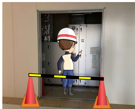
内装工事先行の場合 (分割して搬入し室内での組立)
