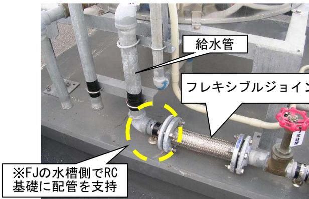
写真-3 給水管の支持不具合例
