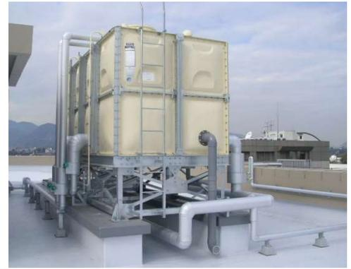
写真-7 高置水槽（FRP製）の配管支持例
